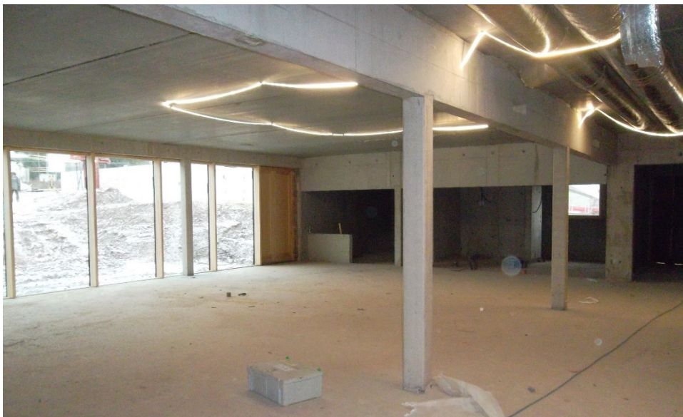
Futur périscolaire – salle de restauration + local cuisine
