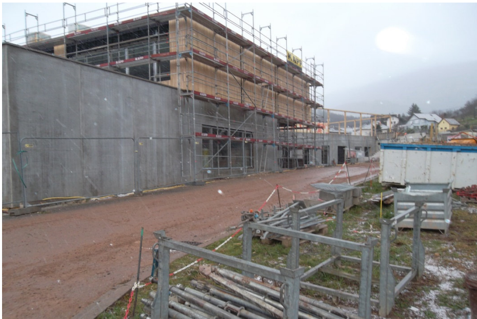
Pose du bardage bois
